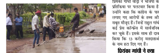
पद्मेश न्यूज़। उकवा। जगपद पंचायत परसवाड़ा के अंतर्गत ग्राम पंचायत उकवा में विकास कार्यों ने फिर से रूठार पकड़ी है जिससे ग्रामीणों में खुशी की लहर देखने मिल रही है। ग्रामीणों में सीसी सड़क आरंभ की नाली बाजार चौक एवं पाणी टोला में सीमेंट लाइट जैसे निर्माण कार्य पूर्ण करने के बाद अब लगभग एक करोड़ 23 लाख 42 हजार की राशि से कार्यवाही का रहे हैं विकास कार्य। नवागत सरपंच श्रीमती रायवती उर्वक उपसरपंच शिव शंकर तिवारी एवं सचिव भवन वलके ने जानकारी देते हुए बताया कि 3 अगस्त 2026 को बिना बगलों पर निर्माण कार्य के लिए भूमि पूजन किया गया था उर्वक सबसे पहले वार्ड नंबर 04 में दुर्गा प्रखंड पटले के घर से बोधवे बाबू के घर तक 40 मी सीसी सड़क, ओम प्लाई स्टोर से बड़ देव परिसर तक सीसी सड़क, बड़ देव परिसर से संबंध अग्रवाल के घर तक सीसी सड़क, संबंध अग्रवाल के घर से सागुलिया भवन उकवा के घर तक सीसी रोड, तिवारी बहारे के घर से ब्रम्ह के घर तक सीसी रोड। वार्ड नंबर 16 में भी तितकबाबू के घर से मेन रोड तक सीसी रोड निर्माण कार्य, बाजार परिसर में गद्दू निर्माण कार्यों का सरपंच श्रीमती रायवती उर्वक उप सरपंच श्री शिव शंकर तिवारी सचिव श्री भवन वलके पंच श्रीमती रीता जीबीतिया ललित रीता प्रेमला मेथन आरती भाद्राज एवं पंच रमेश कुमार बंडेलवा सभापति सुमित मांगे संबंध अग्रवाल केरतो चरण बंडेल नंद एवं सभी पंचायती और ग्रामीणों की उपस्थिति में भूमि पूजन किया गया था उन विकास कार्यों का निर्माण कार्य शुरू कर दिया गया है समुदायिक भवन उकवा के पंच से संबंध अग्रवाल के घर तक 8 इंच मोटी एवं 13 फीट चौड़ी सीसी सड़क का कार्य बोधवे से चल रहा है इसके पश्चात जिन-जिन विकास कार्यों का भूमि पूजन किया गया है उन सभी निर्माण कार्यों का निर्माण कार्य शुरू कर जल्द ही पूरा कर दिया जाएगा। ग्राम पंचायत उकवा के पंच एवं उकवा की जनता का निर्माण कार्यों में सराहनीय योगदान मिल रहा है।
