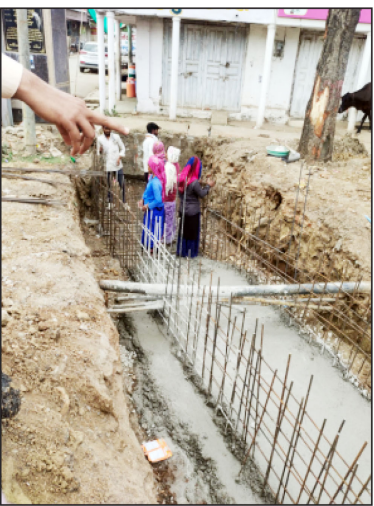
कलेक्टर के माध्यम से नाला निर्माण कराया जा रहा है। सचुना स्थानियों लोगों ने पार्षद को सूचना दी कि नाला निर्माण में गुणवत्ता का ध्यान नहीं रखा जा रहा है तथा कार्य को तत्काल रुकवा दिया। पार्षद का आरोप है कि नाले का निर्माण निर्धारित मानकों के अनुरूप नहीं किया जा रहा था और कार्य में तकनीकी गुणवत्ता का अभाव स्पष्ट दिखाई दे रहा था। उन्होंने कहा कि निर्माण कार्य में प्रशिक्षित तकनीकी श्रमिकों के बजाय सामान्य मजदूरों से काम कराया जा रहा था, जिससे निर्माण की मजबूती और गुणवत्ता पर प्रश्नवाचक खड़े हो रहे हैं। इसके अलावा नाले के भीतर से चाणूलाहन गुजरने जैसी स्थिति भी सामने आई, जिस पर उन्होंने आपत्ति दर्ज कराई। मौके पर ही पार्षद ने निर्माण कार्य को खामियों को लेकर वीडियो बनाकर अपना विरोध दर्ज कराया, जो बाद में सोशल मीडिया पर भी वायरल हो गया। वीडियो के माध्यम से उन्होंने नगर पालिका प्रशासन और निर्माण एजेंसी को कार्यगृहणी पर सवाल उठाए तथा गुणवत्ता से समझौता नहीं किए जाने की बात कही। पद्मेश न्यूज़ से चर्चा करते हुए पार्षद मनीष नेमा ने बताया कि उन्हें वाईवासियों द्वारा फोन कर निर्माण कार्य में अनियमितताओं की जानकारी दी गई थी। इसके बाद उन्होंने स्वयं मीना पर पहुंचकर स्थिति का निरीक्षण किया। उन्होंने कहा कि जनप्रतिनिधि होने के नाते उनकी जिम्मेदारियों को मिलाते ही पार्षद मनीष नेमा निर्माण स्थल पर पहुंचे और कार्य का निरीक्षण किया। निरीक्षण के दौरान उन्होंने निर्माण
